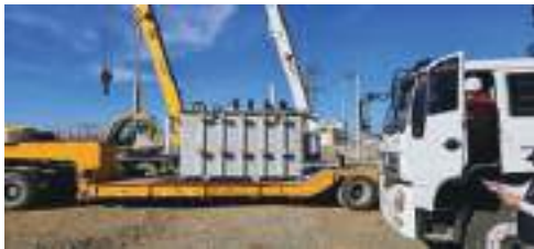
Баянхонгор дэд станцын буусан 6.3 МВА трансформаторыг зөөх ажил хийгдэж байгаа нь
