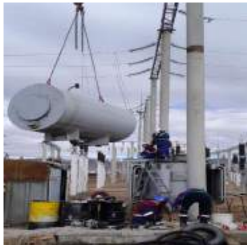
“Мөрөн” дэд станцаас буусан трансформаторыг зөөвөрлөх ажил явагдаж байгаа нь
