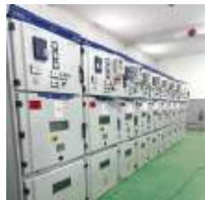
10 кВ-ын ячейкууд шинээр суурилагдсан
