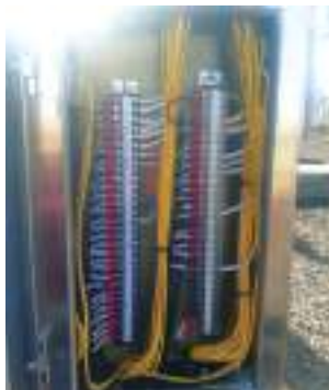
Зураг 1: Холболт монтаж хийсэн байдал
