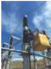
Сонгино дэд станцын 220 кВ-ын ХТ сольж байгаа нь
